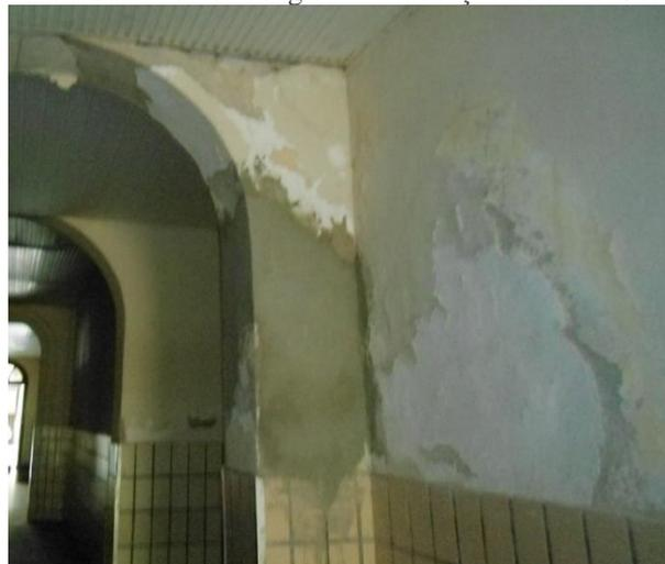
**Figura 8:** Fissuras em um dos pilares principais do espaço de convivência da universidade UVA. Sobral - CE, 2017.
