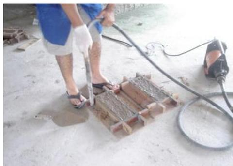
Figura 4. O processo de retirada de bolhas através de vibração produzida por um vibrador de imersão.
